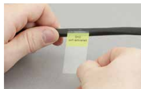
Закрепить маркировочный элемент на поверхности
