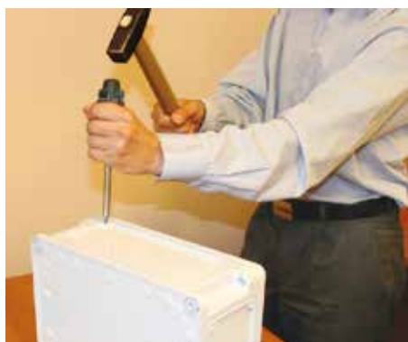
1. Удалите соединительные отверстия
